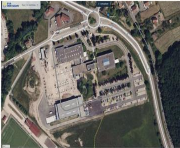
Vue aérienne récente (© Michelin - 2021/2022), sur laquelle on peut apercevoir les travaux d'extension (encore en cours sur cette photo, achevés en 2023) mais également les « aménagements dits complémentaires », objet de cette révision (nouvelle voie de contournement de l'entreprise déjà en place !).
