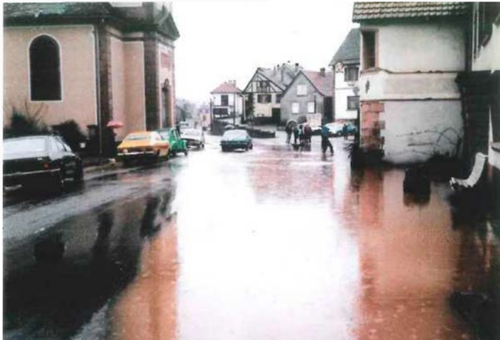
^ Inondation du 9 avril 1983 à Triembach-au-Val (photo JL BOEHLER)
