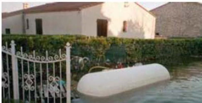
Cuve soulevée par l'eau
