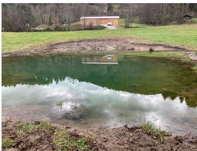
Création d'une mare à proximité d'un nouveau bâtiment d'élevage
