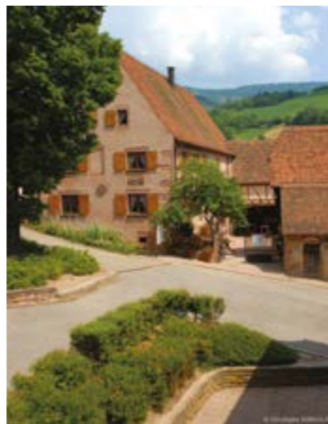
RÉHABILITATION DE LA PISCINE : 1997
